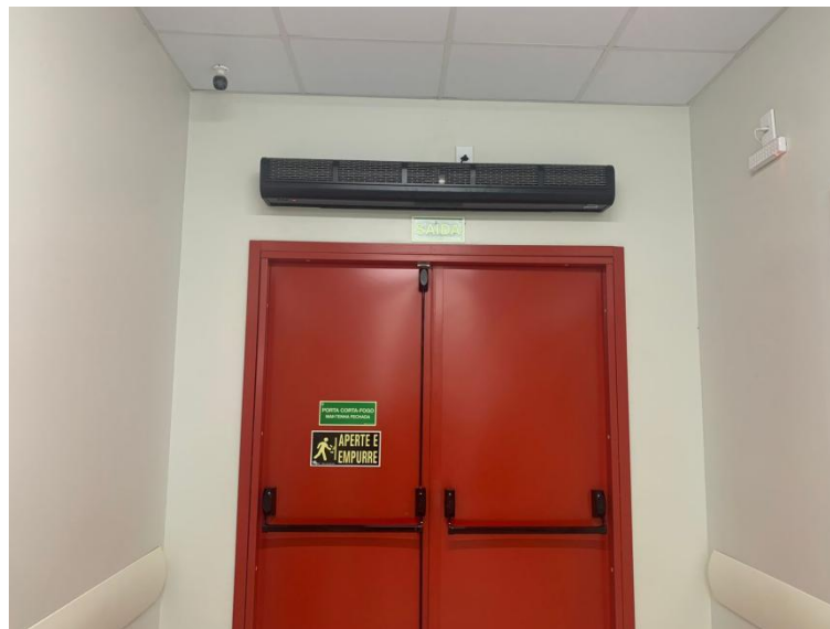
Instalação de cortinas de ar
