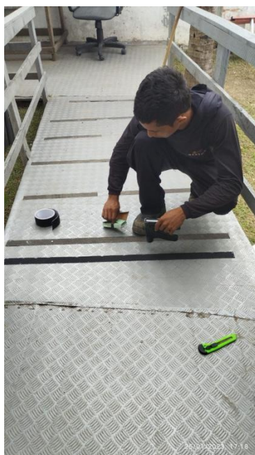
Figura 1: Troca de adesivo antiderrapante
